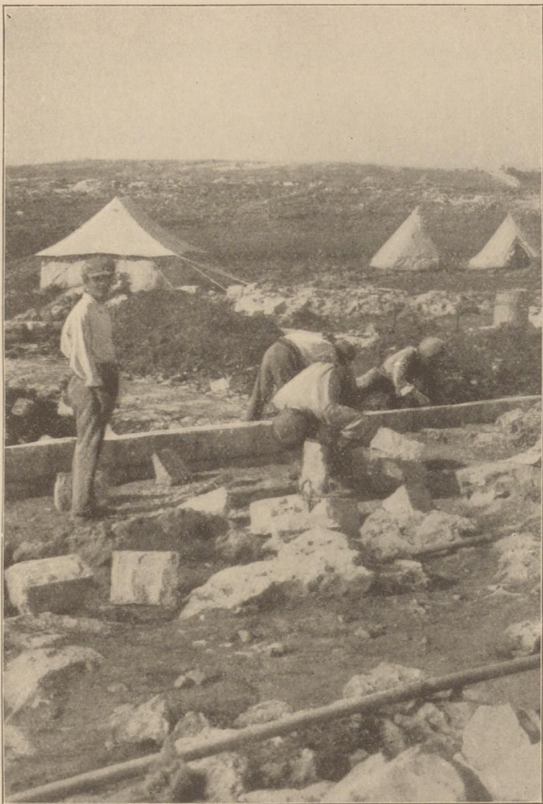
Jerusalem. Beth Hakerem quarter, Beginning of a construction in stone, Lime slaking Jerusalem. Stadtviertel Beth Hakerem, Beginn eines Steinbaues, Kalklöschen
