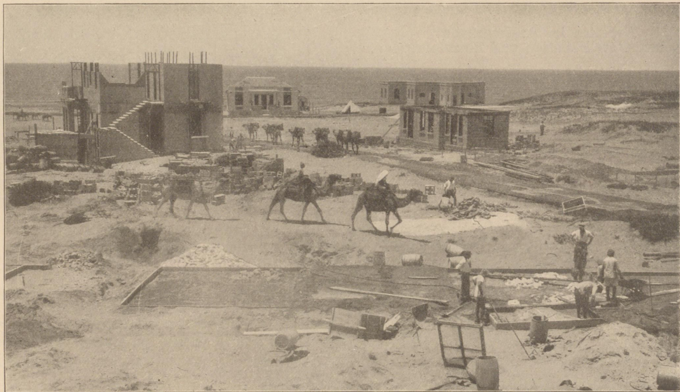
Tel-Aviv. Construction of a concrete road Tel-Aviv. Bau einer Betonstraße
