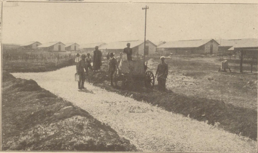
Sarafend. Construction of a road for the military administration Sarafend. Chausseebau für die Militärverwaltung
