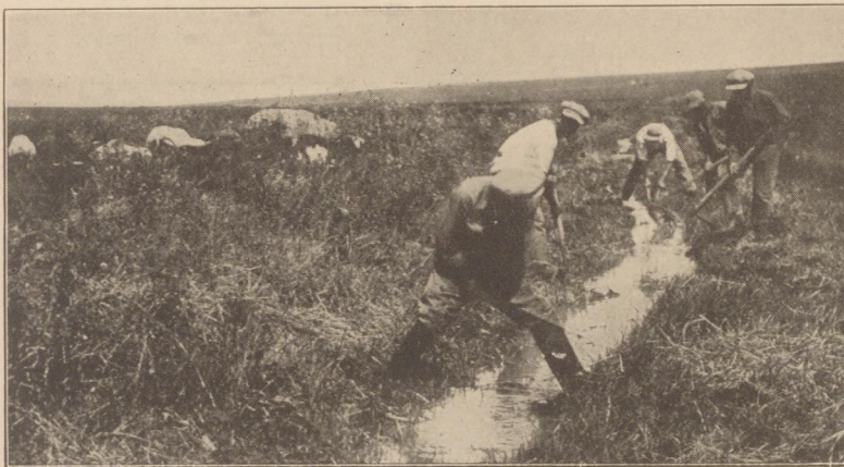
Ein-Harod. Drainage work Ein-Harod. Drainage-Arbeit
