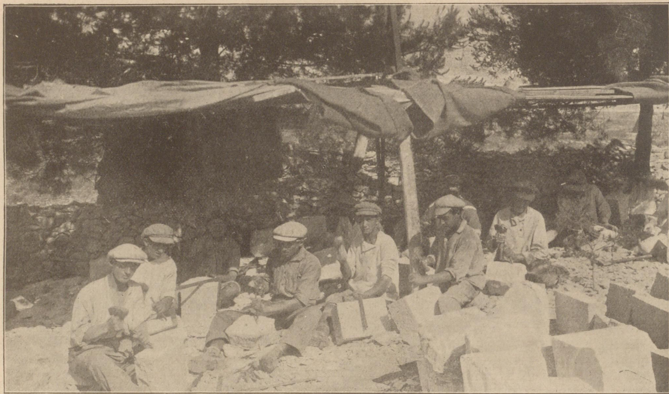
Stone industry. Fine stone dressing Steinindustrie. Feinere Steinmetzarbeiten
