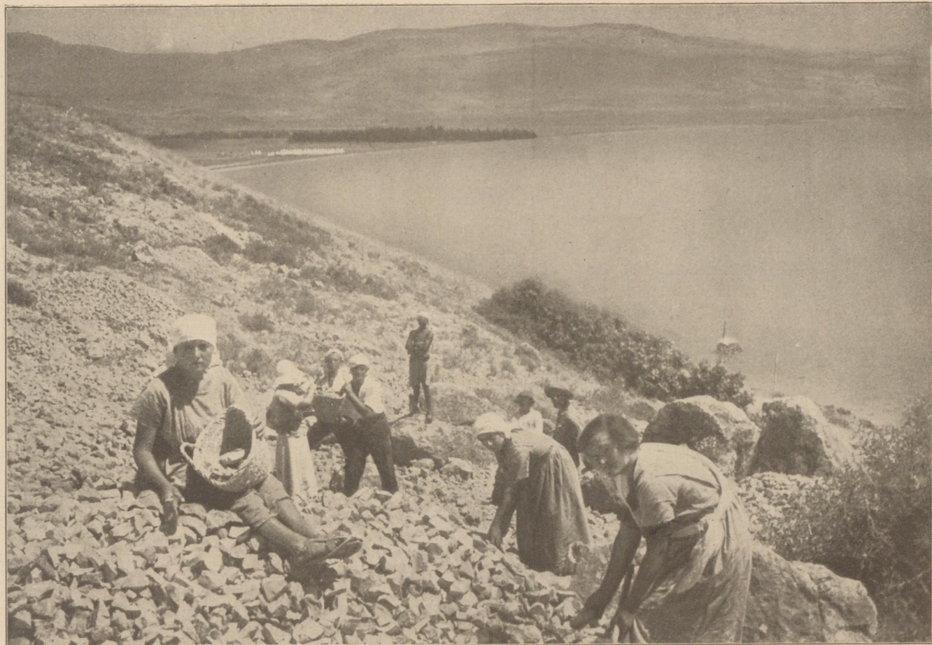
Tiberias-Semakh road. Preparation of metalling Chaussee Tiberias-Semach. Herstellung von Schottersteinen
