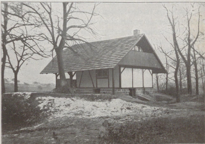
Das fertige Haus
