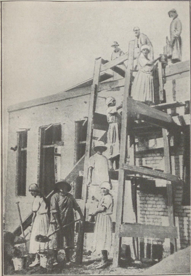
Eine Gruppe von Frauen bei der Bauarbeit.
